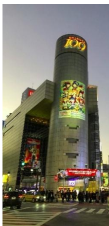
Imagem 3: vista do edifício shopping a partir do cruzamento de sinais da rua
